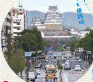
1 JR姫路駅(姫路城眺望デッキ「キャスルビュー」) 世界遺産姫路城への玄関口として、JR姫路駅前の 姫路駅北駅前広場に整備された展望施設。 姫路城大天守を正面から眺望できます。
