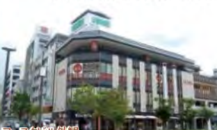
フェスタビル外観
